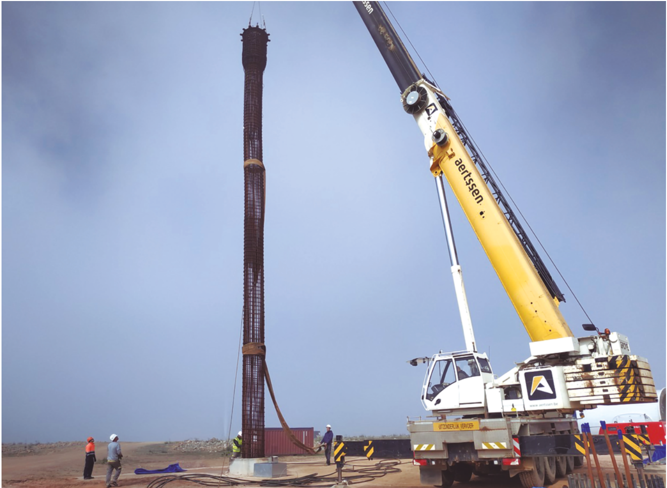
Colocación de la ferralla de la cimentación pilotada en el parque eólico de Oualidia (Marruecos). El innovador concepto de cimentación empleado en el proyecto fue reconocido en la edición de 2023 y constituye una de las soluciones técnicas más destacadas desarrolladas para este tipo de instalaciones.
