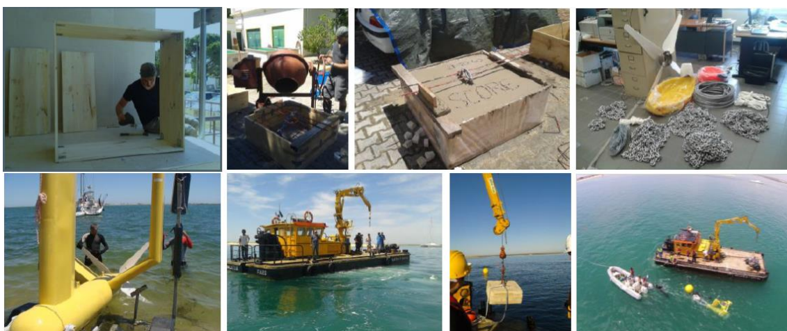
Figura 2. Preparación, instalación y operación del prototipo de energía de marea Evopod E1 de la compañía británica OceanFlow Energy en la barra de Ría Formosa de Faro-Olhão, bajo el proyecto SCORE financiado por FCT
