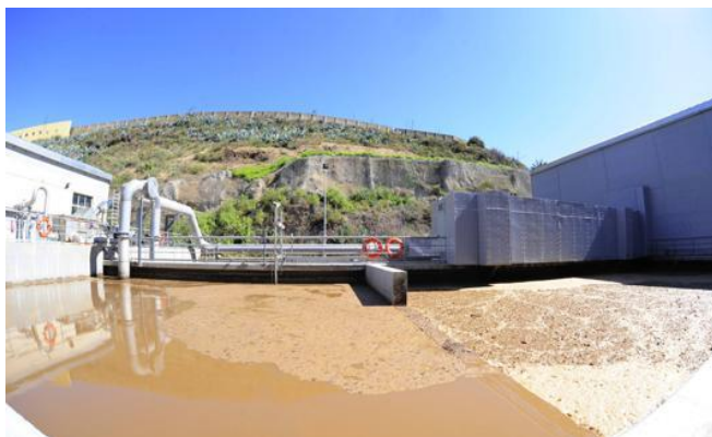
Depuradora de Las Majadillas.
