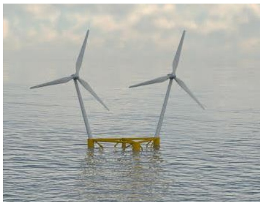
Plataforma Eólica W2Power
